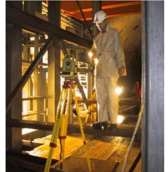
Schachtfuss: Reflektor mit Leuchtdiode auf „Verschiebetisch“ / „Kreuzschlitten“
